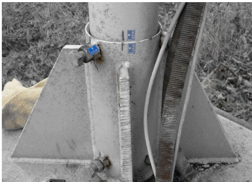
Obr. 146 Označení polohy nosného sloupu skříně RAMER10 O k základně
